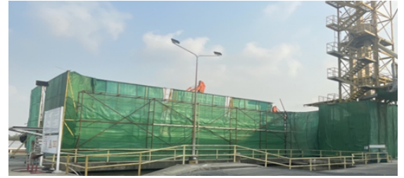
การติดตั้งสแลน เพื่อป้องกันฝุ่นจากกิจกรรมรับข้าวจากเรือเข้าท่า
